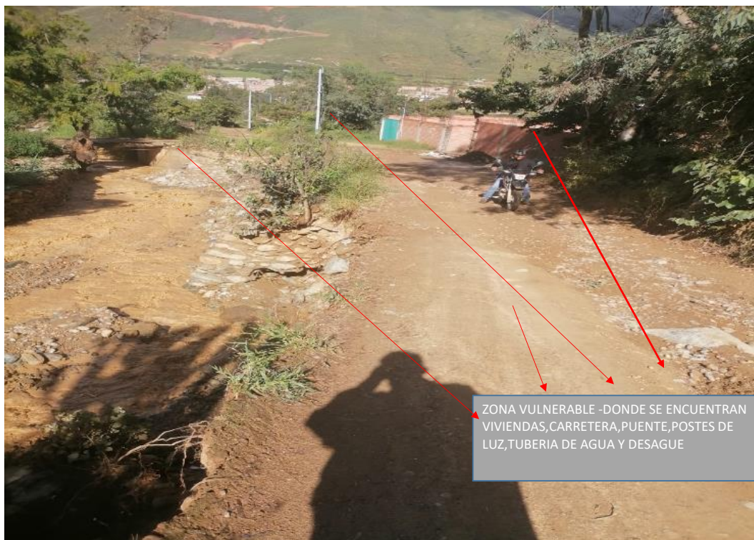
FIGURA N°03: EN LA TEMPORADA DE MAXIMAS EROSION, EL RIO EROSIONA EN LA MARGEN IZQUIERDA DE LA POBLACION DE HUAMANGAGA.
